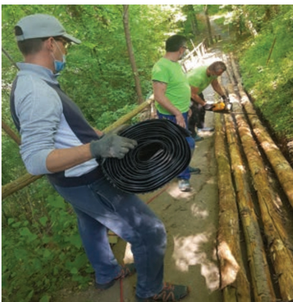
Za izdelavo pregrade smo uporabili stebila posušenih smrek (sušice) Foto: Nina Šauprel
