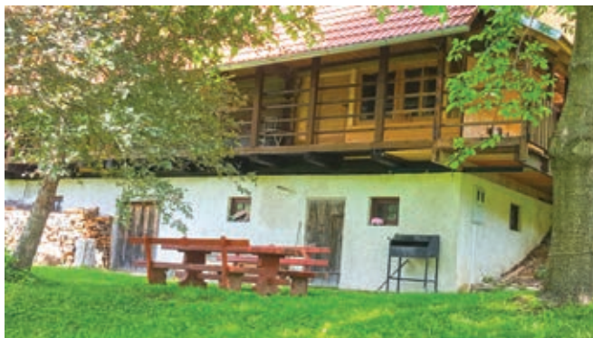
Obnovljena stavbna arhitektura omogoča starejšim udeležbo na srečanjih, predavanjih in drugih oblikah izobraževanja (kmetija Vrhivšek). Foto: Iz arhiva
