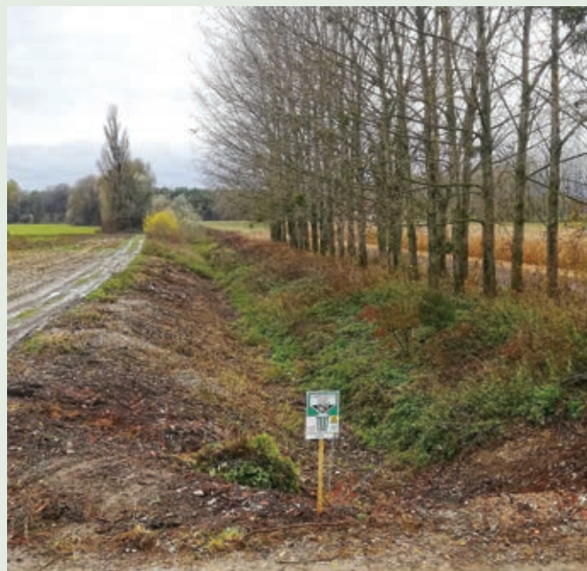
Končana sanacija odlagališča v naselju Vurberk Foto: Borut Ludvik
