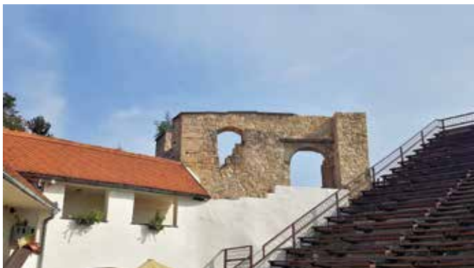
Pogled na obnovljen kamniti portal peterokotnega stolpa
