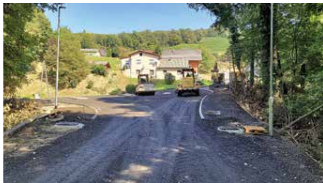
Območje izvedbe del
