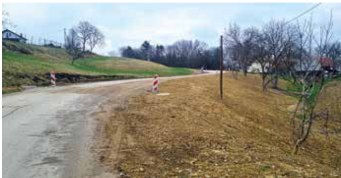
Sanirano območje plazov pred izvedbo zaključnih del
