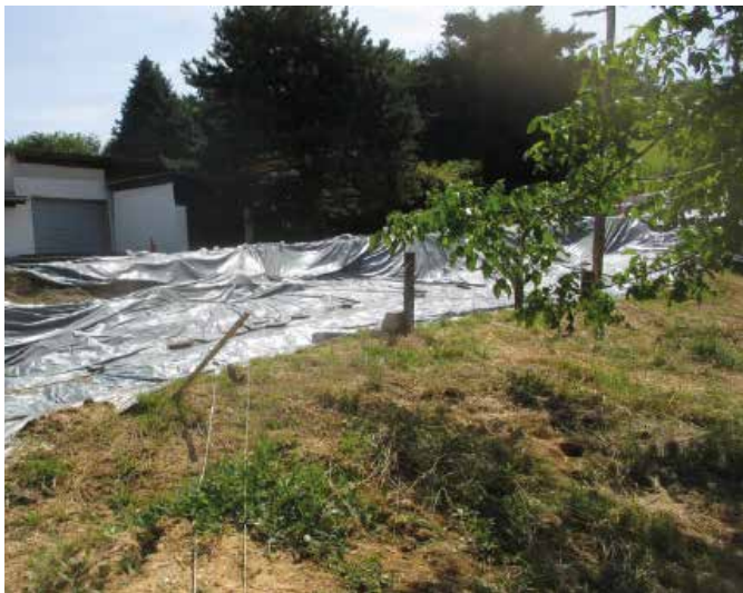
Pogled na odlom (prekrit s folijo) z brežine pod voziščem
