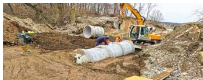
Izvedba cevne prepusta
